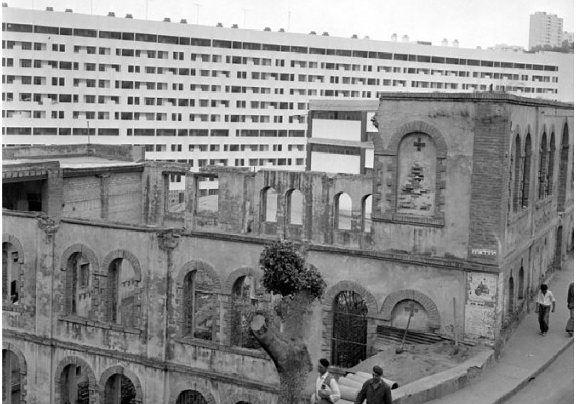
Construction d'immeubles à Alger, dans le cadre du plan de Constantine
